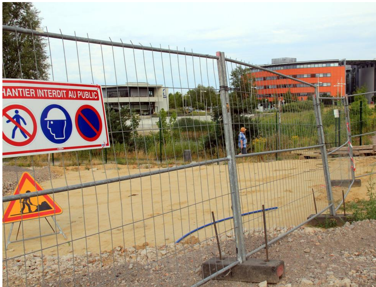
Au bord du lac artificiel, un hôtel trois étoiles est en construction. PHOTO DNA - SOPHIE WEBER
