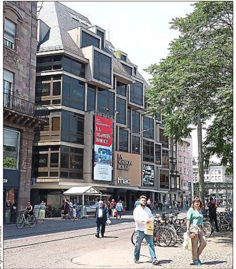
Une rénovation, mais sans révolution esthétique pour le futur bâtiment.
